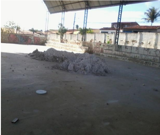
Quadra desportiva- deposito de materiais
