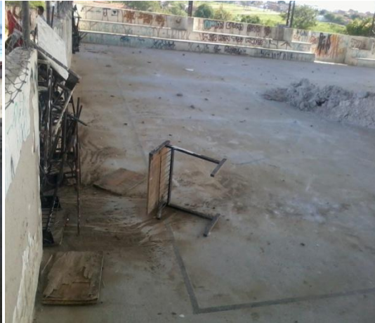
Quadra desportiva- deposito de materiais II
