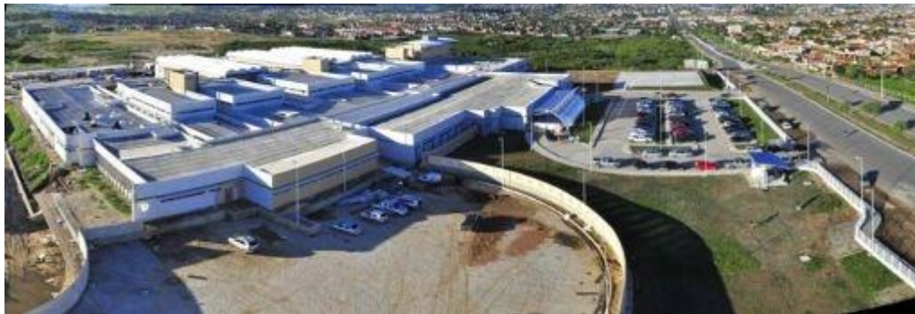
Figura 2 – Hospital Público Regional de Campina Grande, estado da Paraíba.
