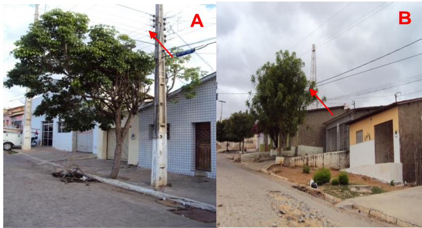
Figura 13 A e B. Conflitos com a fiação elétrica na cidade de Boqueirão/PB, 2013.
