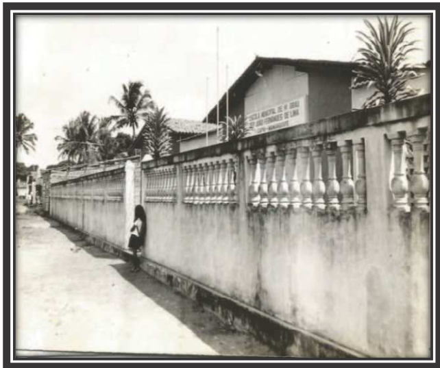
Foto 3. Fachada da Escola antiga
