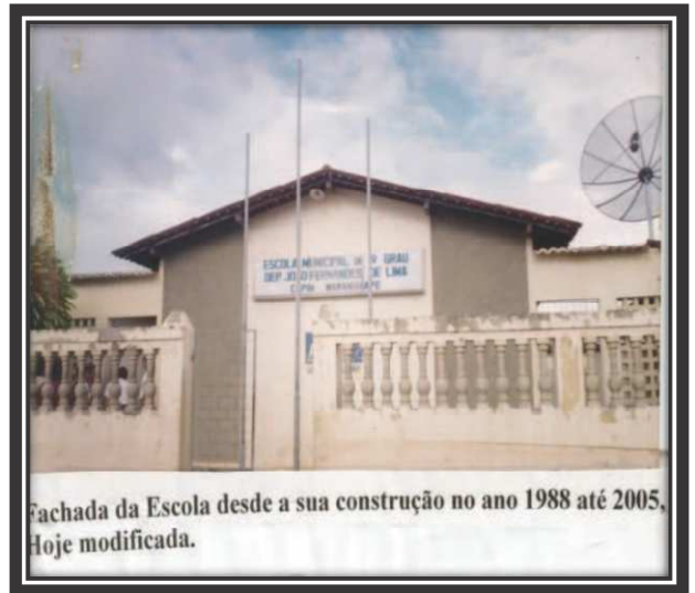
Fachada da Escola desde a sua construção no ano 1988 até 2005, Hoje modificada. Foto 4. Fachada no ano de 1988 até 2005
