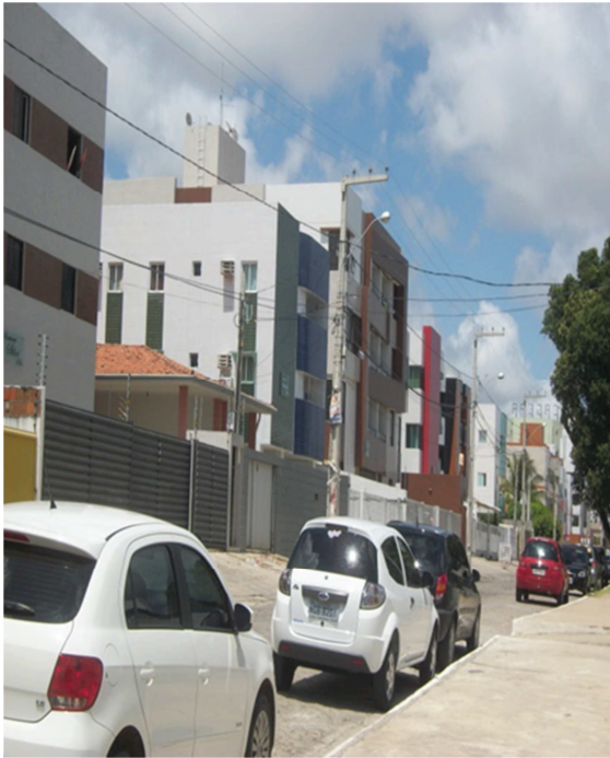
Edifícios da Rua Esmeraldo Gomes Vieira
