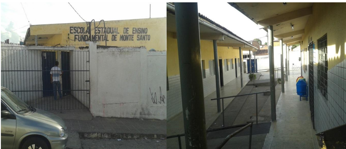
Figura 01: Escola Estadual de Ensino Fundamental do Monte Santo. Fonte: DANTAS, J. O. R, 2014
