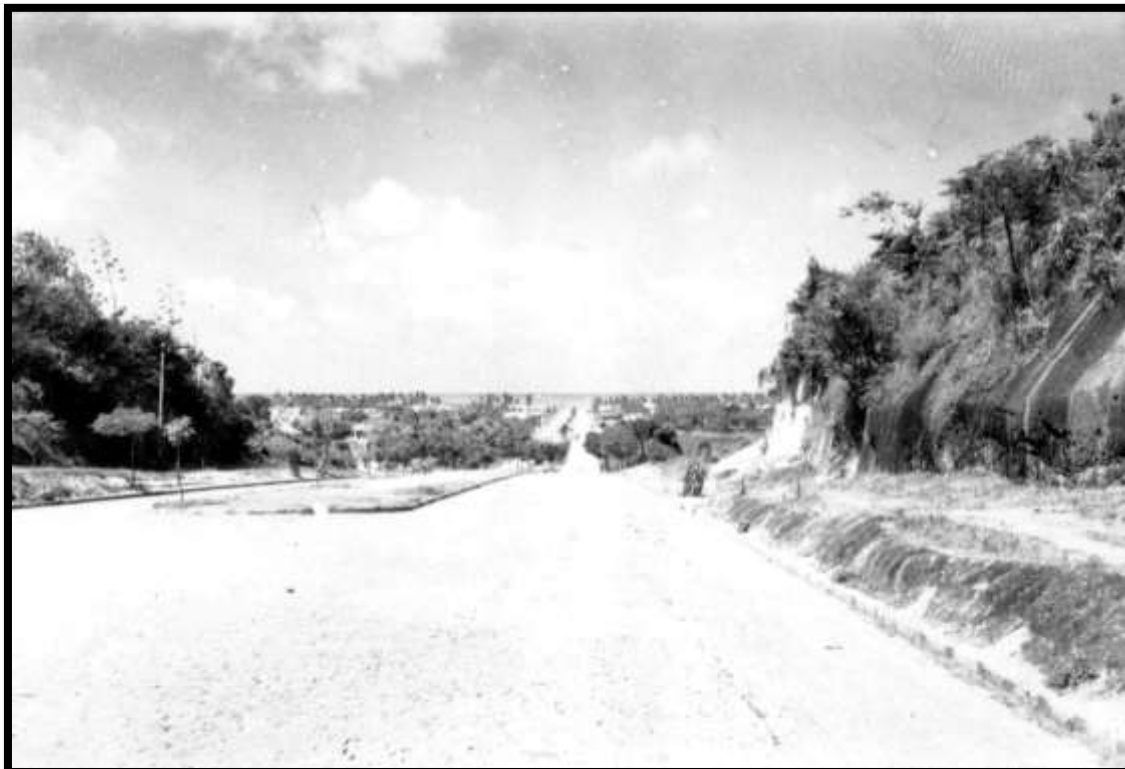
Figura 4 - Descida da Avenida Eptácio Pessoa já pavimentada.
