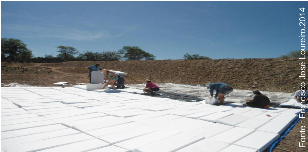
Figura 2: Montagem da cobertura para redução da evaporação
