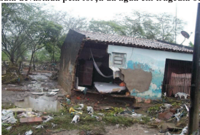
Figura 9: Moradia devastada pela força da água em tragédia ocorrida em 2011
