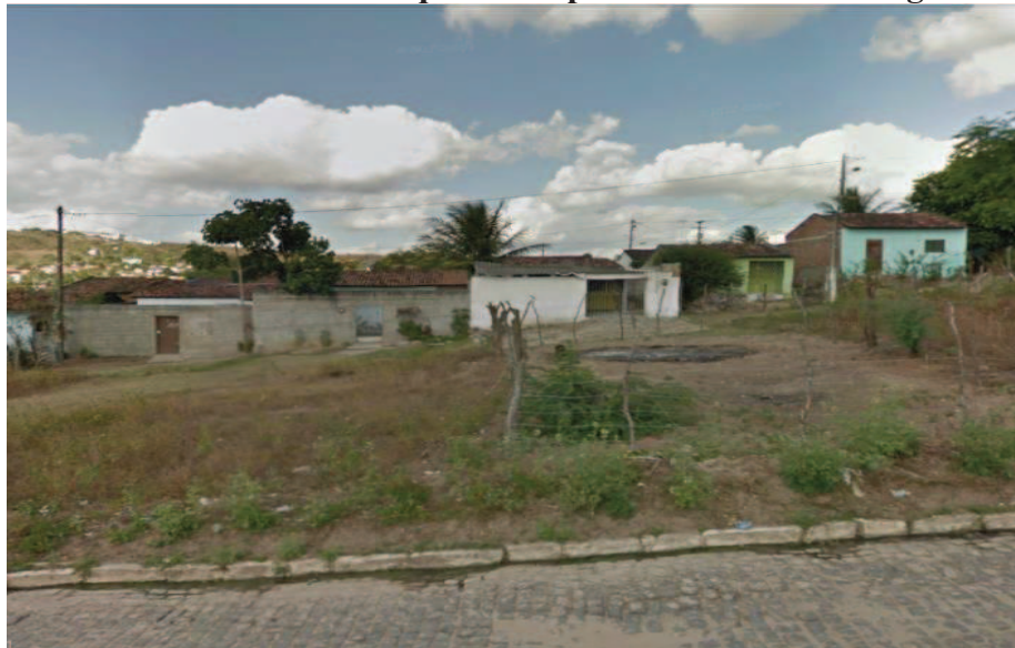
Figura 5: Casas autoconstruídas que correspondem à área 3 da Figura 3.
