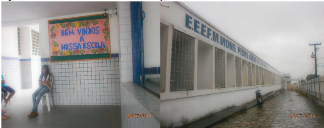
Figura 1 – Entrada da escola e sua fachada, respectivamente.
