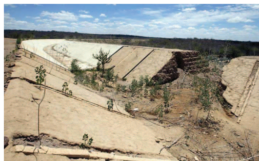
Foto 3 - Trecho da obra de transposição do Rio São Francisco
