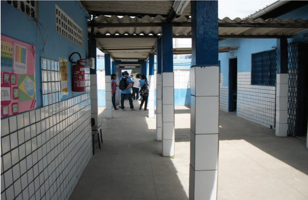
Figura 3: Corredor de saída da E. E. E. F. M. Carlos Chagas.
