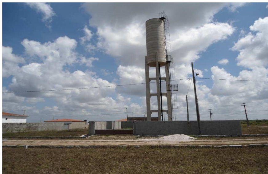
Figura 3 – Caixa d'água construída no loteamento Nova Jacaraú. Fonte: PESSOA, Novembro de 2011.
