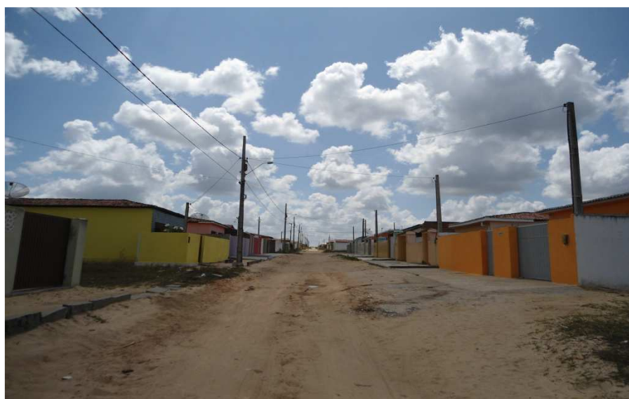
Figura 4 – Vista de uma das ruas do loteamento Nova Jacaraú. Fonte: PESSOA, Novembro de 2011.
