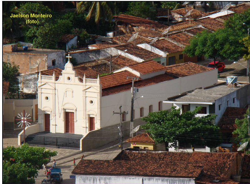
Figura 02: Igreja de São Sebastião, Pilõezinhos/PB. Foto: Jaelson Monteiro.
