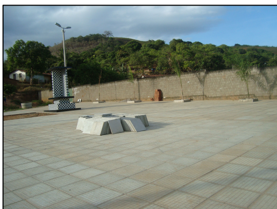
Praça Mª Verônica Cavalcanti de Souza (sítio Mandú), ainda em construção. Foto: autora.
