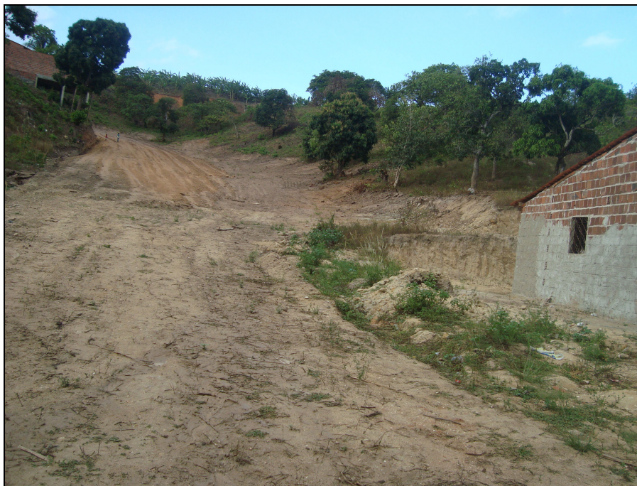
Figura 14: Loteamento, área onde está acontecendo desmatamento para construção de casas na zona urbana de Pilõezinhos. Foto: Cássia Maria de Souza Gonçalo.
