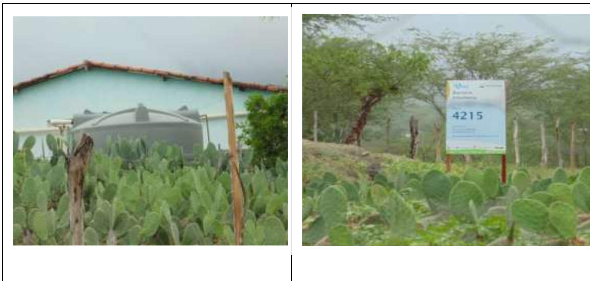
Figura 16: Cisterna de polietileno.
