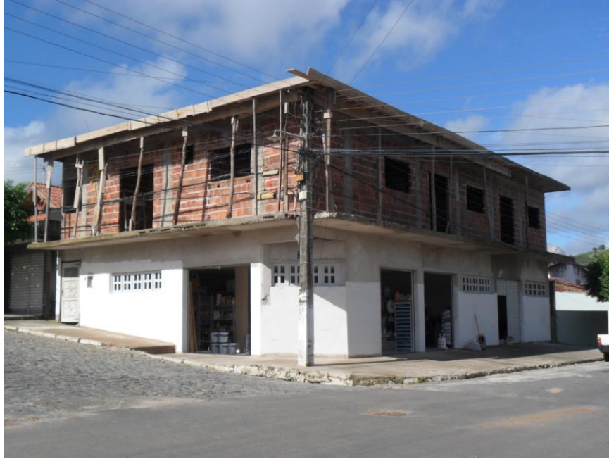
Figura 5: Transformação de imóvel em um edifício vertical Fonte: Pesquisa de campo, 2011.
