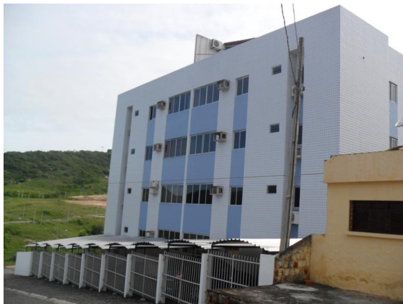
Figura 7: Edifício construído no bairro Novo Fonte: Pesquisa de campo, 2011.
