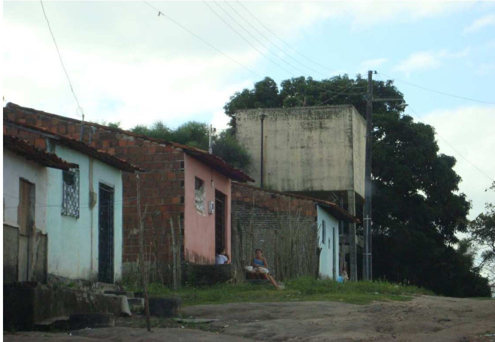
FOTO: Caixa d'água que abastece o bairro. FONTE: FELICIO - 2011
